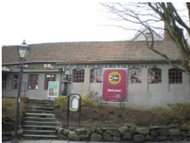
Fot. 1. Widok budynku muzeum
