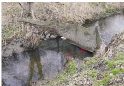
Przeszkoda dla ryb łososiowatych, płynących na tarlisko (na czerwono zaznaczono miejsce umożliwiające przejście ryb przez przeszkodę; strzałka wskazuje miejsce zamontowania video-licznika)
