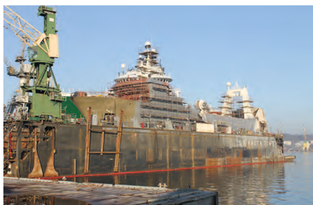
Polonus w trakcie przebudowy
