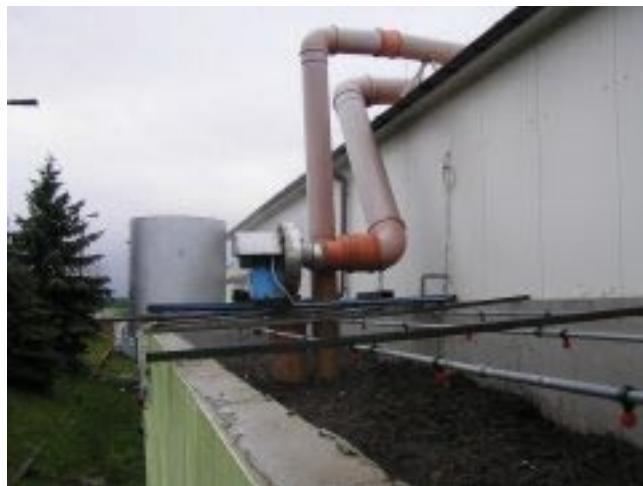
Fot. 1. Biofiltr B6 prostopadłościenny w murowanej obudowie z natryskami do ewentualnego nawilżania biomasy – złoża materiału filtracyjnego.
